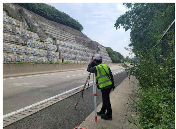
광파기를 이용한 경사도 측정
