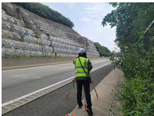
광파기를 이용한 측량 작업
