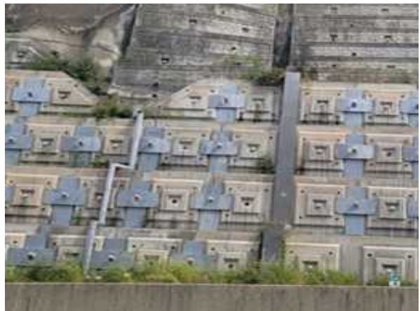
주변영향인자(절토사면부, 배수시설) 상태현황
