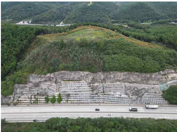
주변영향인자(절토사면부, 배수시설) 상태현황
