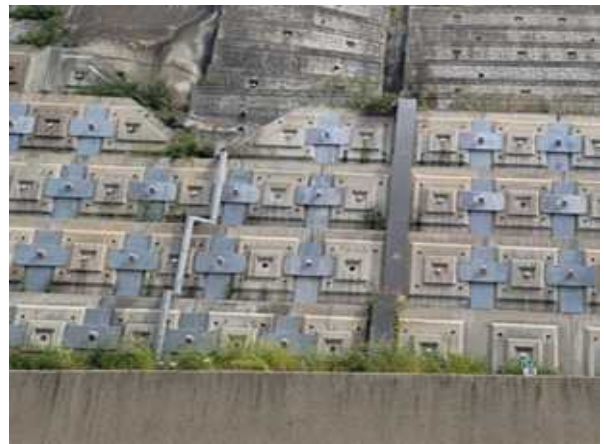
배수관, 배수로 전경
